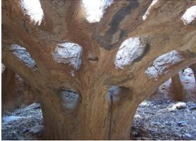
Las dimensiones aproximadas del horno que nos ocupa son de 1,5 metros de diámetro del cilindro por 1,5 metros de altura para la cámara de cocción, y la altura de la cámara de combustión es aproximadamente la mitad. Este diseño, con apenas variaciones, admite dimensiones mucho mayores como, por ejemplo, el horno comunal que operaba en Buño (la Coruña) hasta los años ochenta del siglo pasado.
