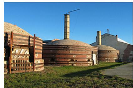
En ocasiones estos hornos eran el centro de la estructura de la fábrica, por lo que pueden encontrarse hornos circulares sobre los que se apoya una estructura (de madera o de fábrica) que aloja otras dependencias auxiliares.
