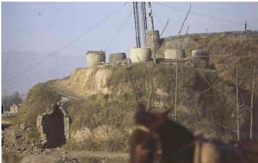
Exterior de un horno chino para cocer ladrillos diseñado para reducción con gas de agua. Observar las cinco grandes vasijas para el agua situadas sobre el techo del horno. La reducción por hidrógeno (como a veces se conoce) puede ser altamente explosiva y ha de efectuarse con precaución. Provincia de Henan, norte de China.
